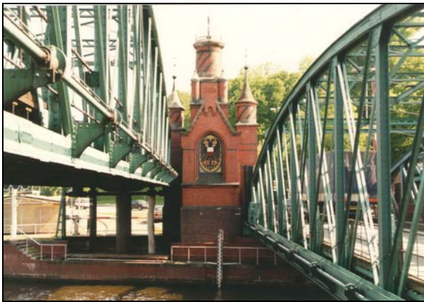
Eisenbahn- und Straßenhubbrücken
