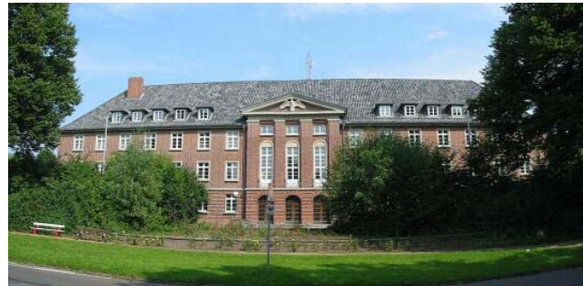
Dienstgebäude WSA Lübeck
