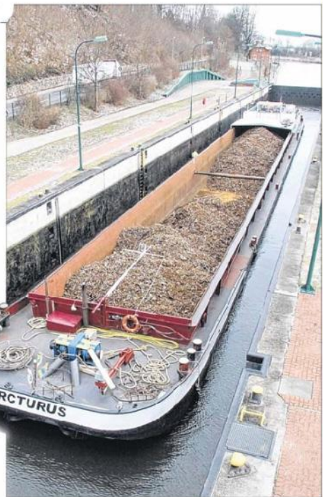
2006 wurde Lauenburgs neue Kanalschleuse für 35 Millionen Euro erbaut. 2012 passierten das Bauwerk 1417 Frachter und 4184 Sportboote.
